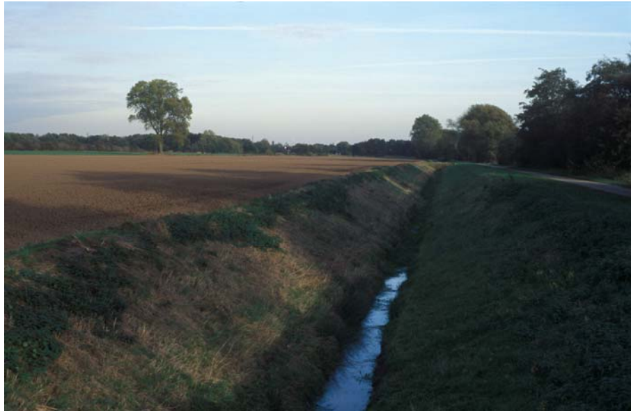
Abb. 4: Nur mit Hilfe von Drainagegräben gelingt es, das niedrig gelegene Land am Rand der Arberger Marsch zu entwässern.
